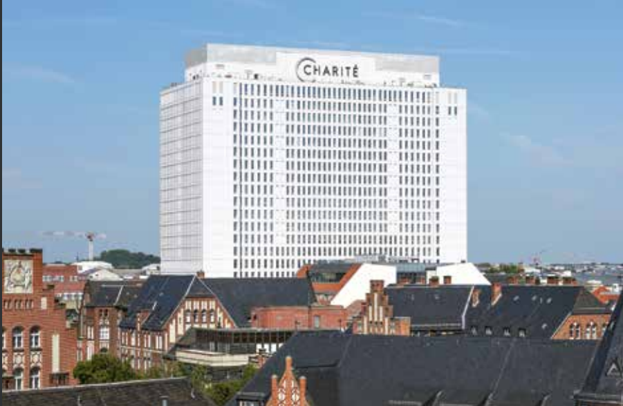
Bettenhaus am Campus Charité Mitte: In Klinikkomplexen dieser Größenordnung sind Aufzüge Teil der kritischen Infrastruktur
