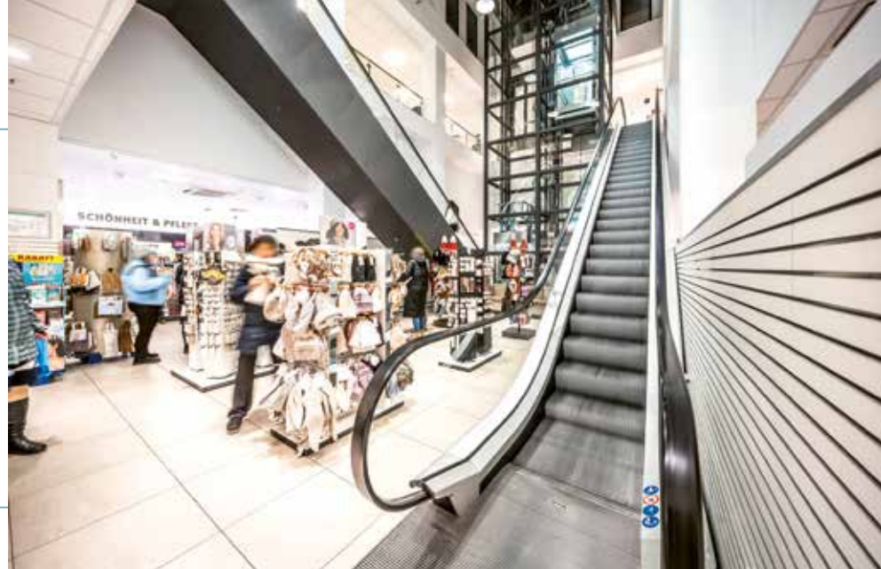
Moderne Fahrtreppen kommen auch im Einzelhandel zum Einsatz
